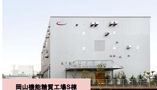
岡山機能糖質工場S棟
