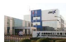
中国：長瀬精細化工(無錫)有限公司 研究開発棟
