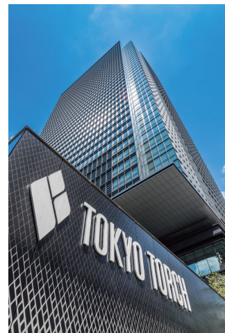
常盤橋タワー 提供:三菱地所株式会社
