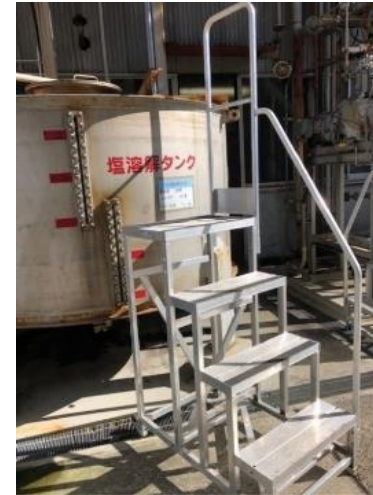
作業ステップへの手すり設置
