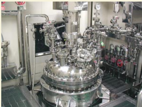
治験原薬精製設備(クラス10万管理クリーンルーム)
