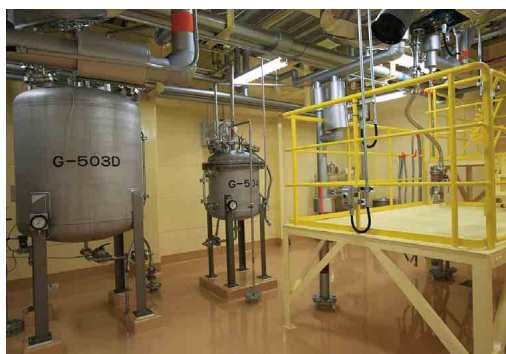
リン脂質製造設備 (ナガセケムテックス(株)福知山工場)
