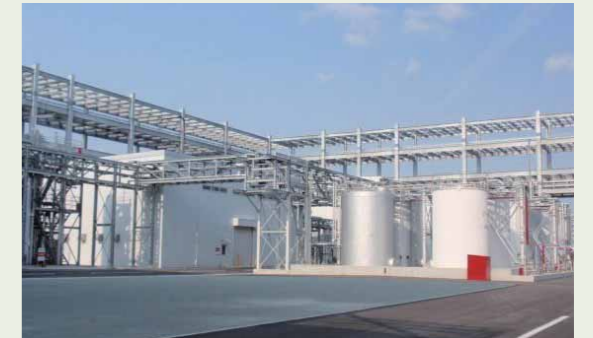
シャープ(株)「グリーンフロント 堺」内の薬液リサイクルプラント
