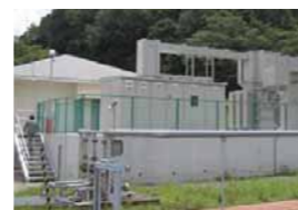
特別高圧受電設備
