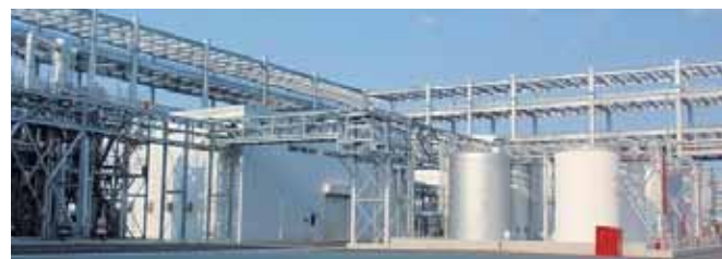
「グリーンフロント 堺」内の薬液製造・リサイクルプラント
