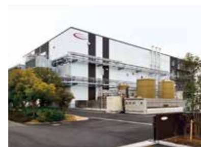
新・岡山第一工場
