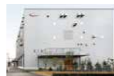
岡山機能糖質工場・S棟
