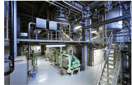
岡山機能糖質工場
