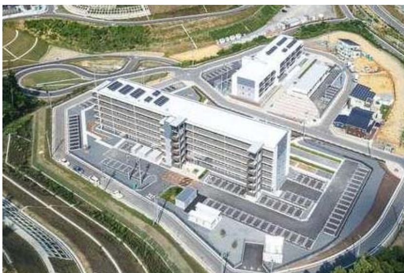
太陽光発電が設置された町営女川住宅
