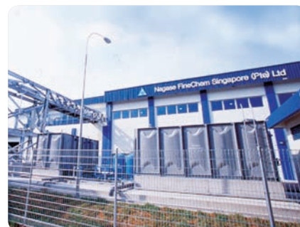
药液再生利用 Nagase FineChem Singapore (Pte) Ltd.
