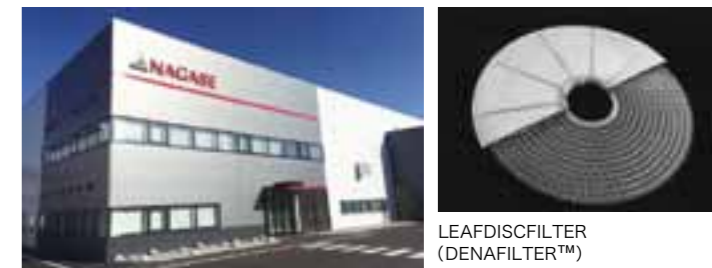
长濑Filter株式会社新大楼
