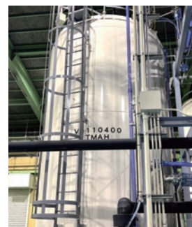
显像液(TMAH)储罐
