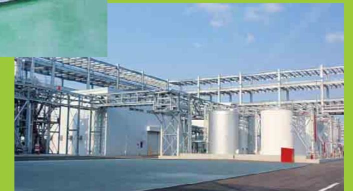
シャープ(株)「グリーンフロント 堺」内の薬液リサイクルプラント
