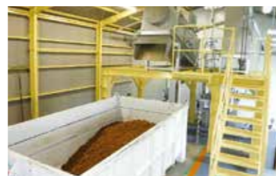
汚泥減容化設備
