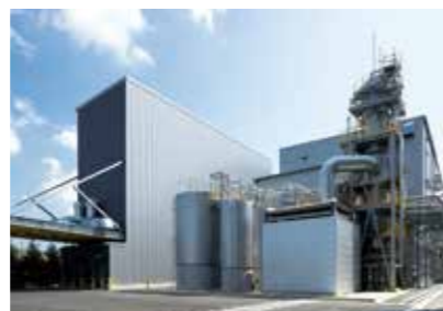
岡山機能糖質工場・T棟
