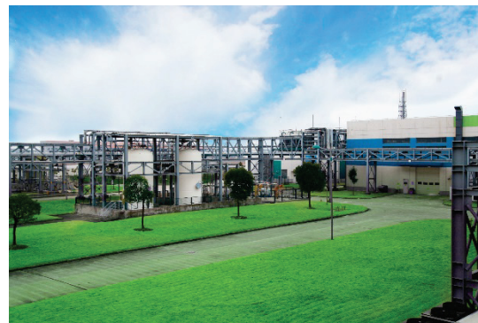
无锡三开高纯化工有限公司の工場
