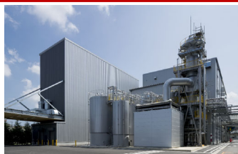
岡山機能糖質工場・T棟
