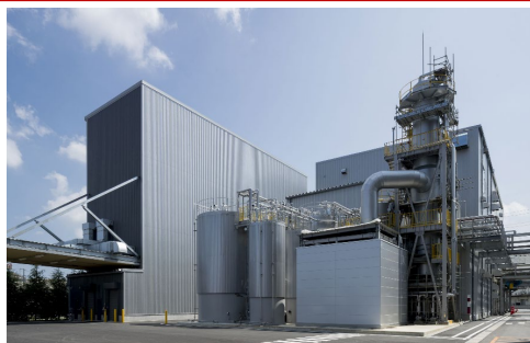
岡山機能糖質工場・T棟
