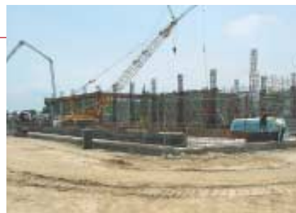
シンガポールに建設中の工場
