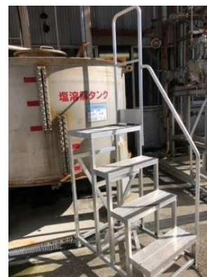
作業ステップへの手すり設置
